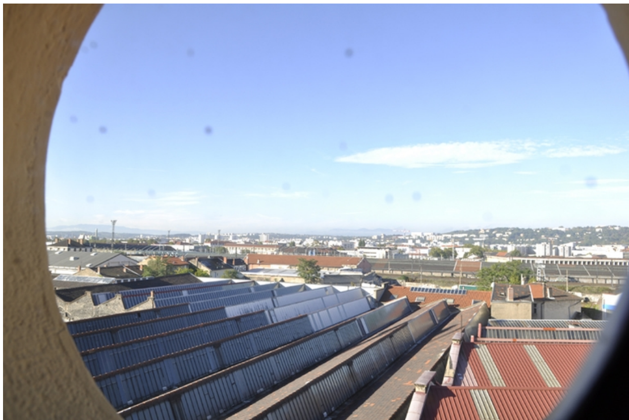
Vue d'ensemble des toitures
