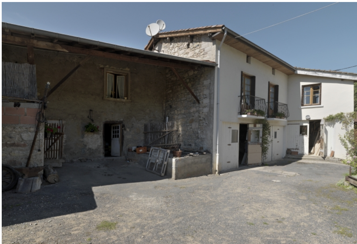
Atelier bois et habitation
