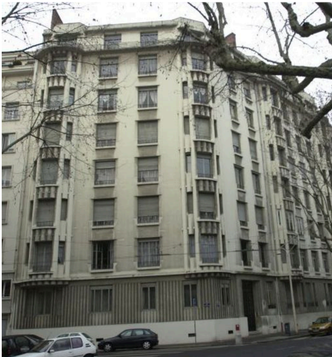
Vue générale de l'élévation
