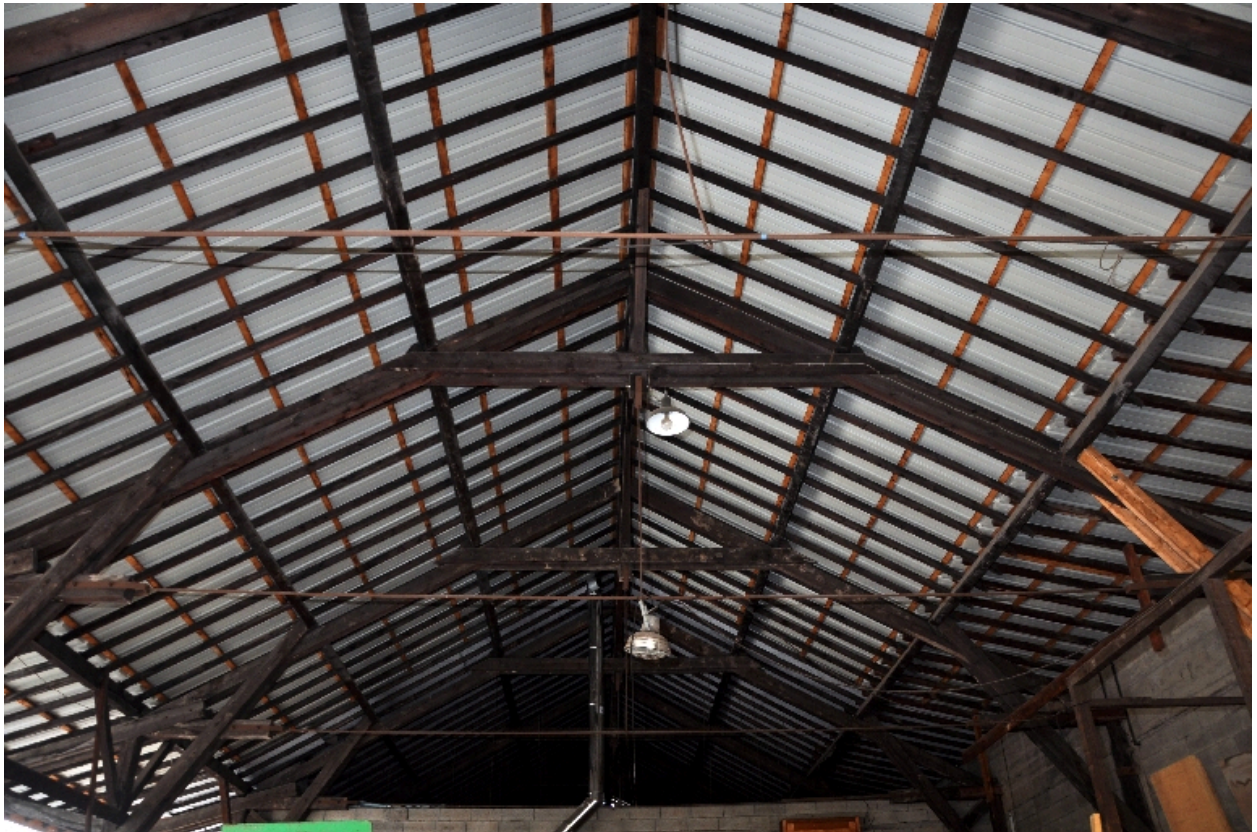
Charpente d'un hangar
