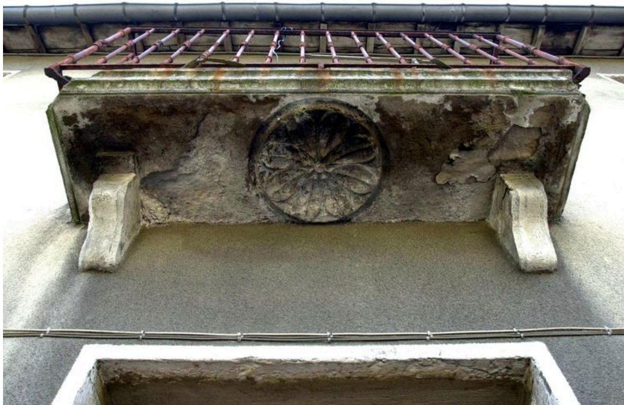
Maison alignée sur rue : rosace ornant la partie inférieure du balcon
