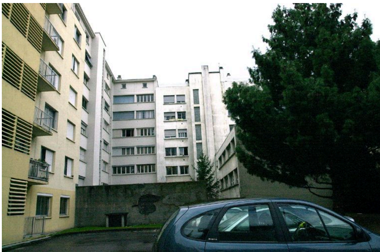
Elévation postérieure depuis le nord
