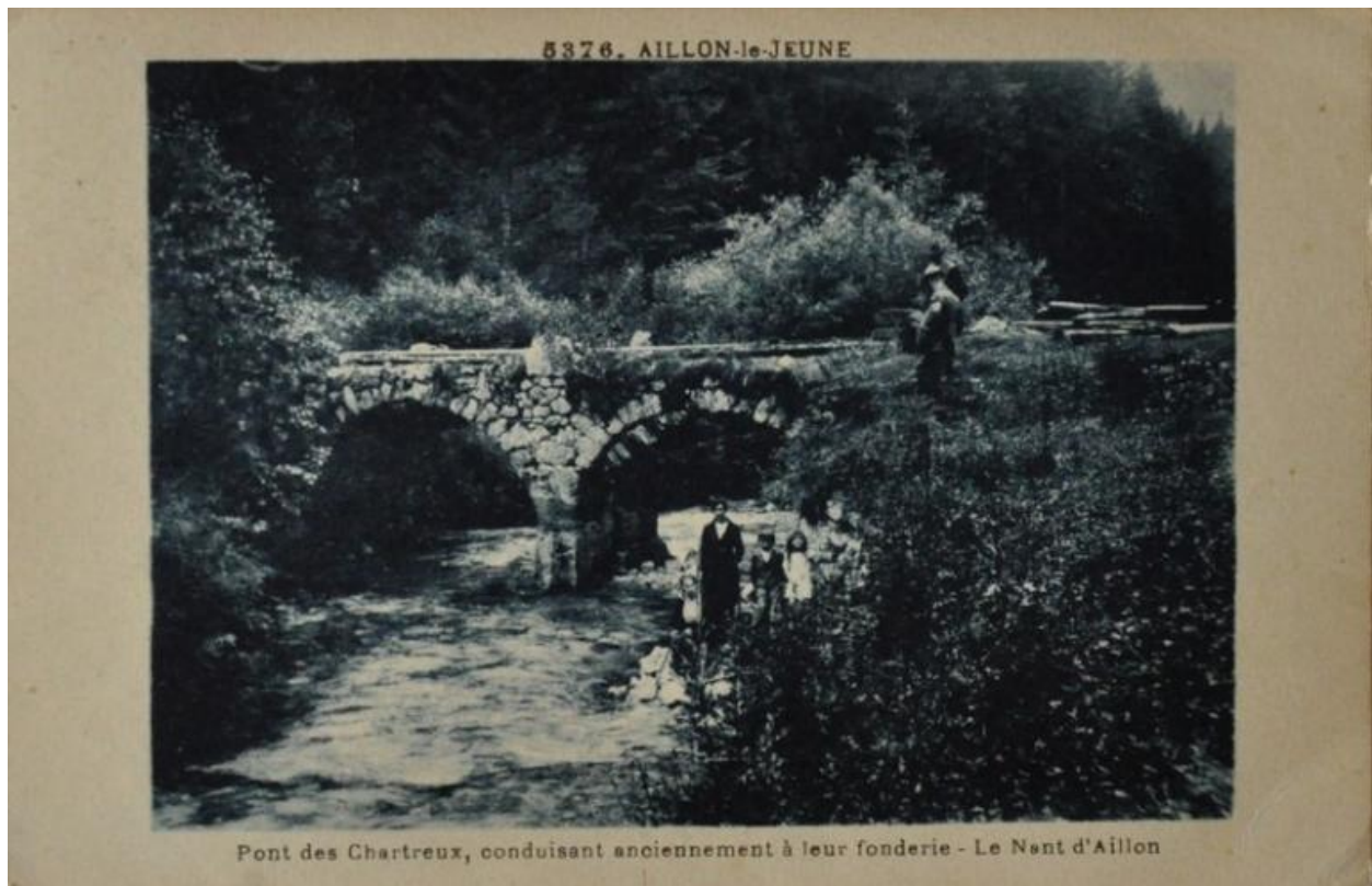
Ancien pont menant au site (© Collection particulière M.-A. Podevin).
