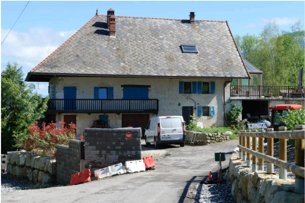
D4 248, 249, Pré Parnan, ferme. Vue d'ensemble de face.
