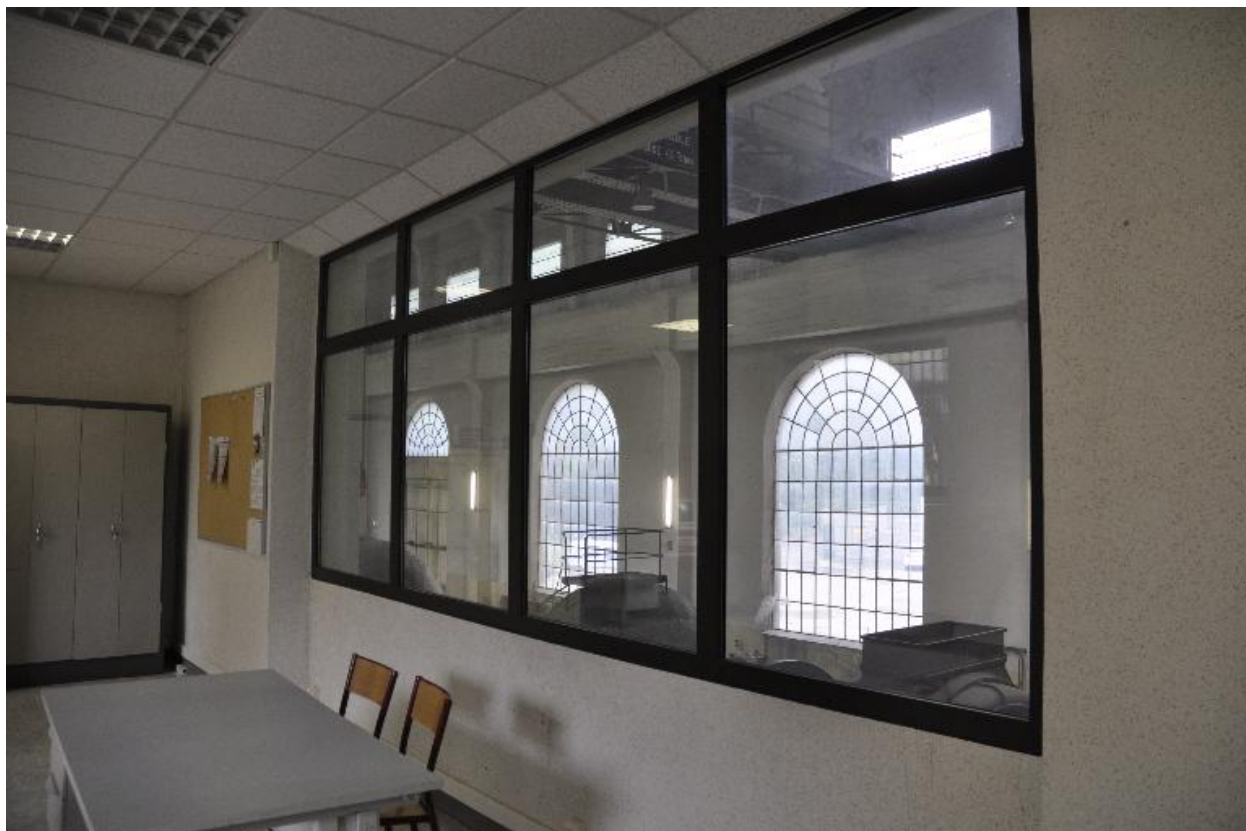
Détail de la baie des bureaux donnant sur la salle des machines
