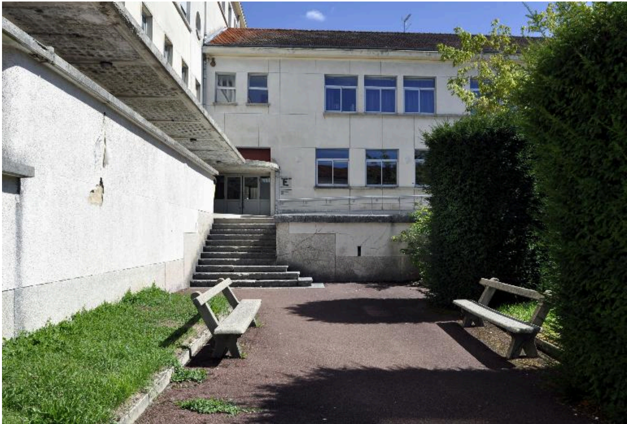
Bâtiment E, élévation sur cour, vue partielle depuis la 1ère terrasse
