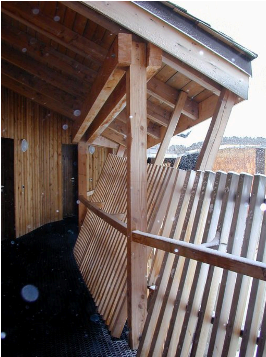
Détail de la galerie principale
