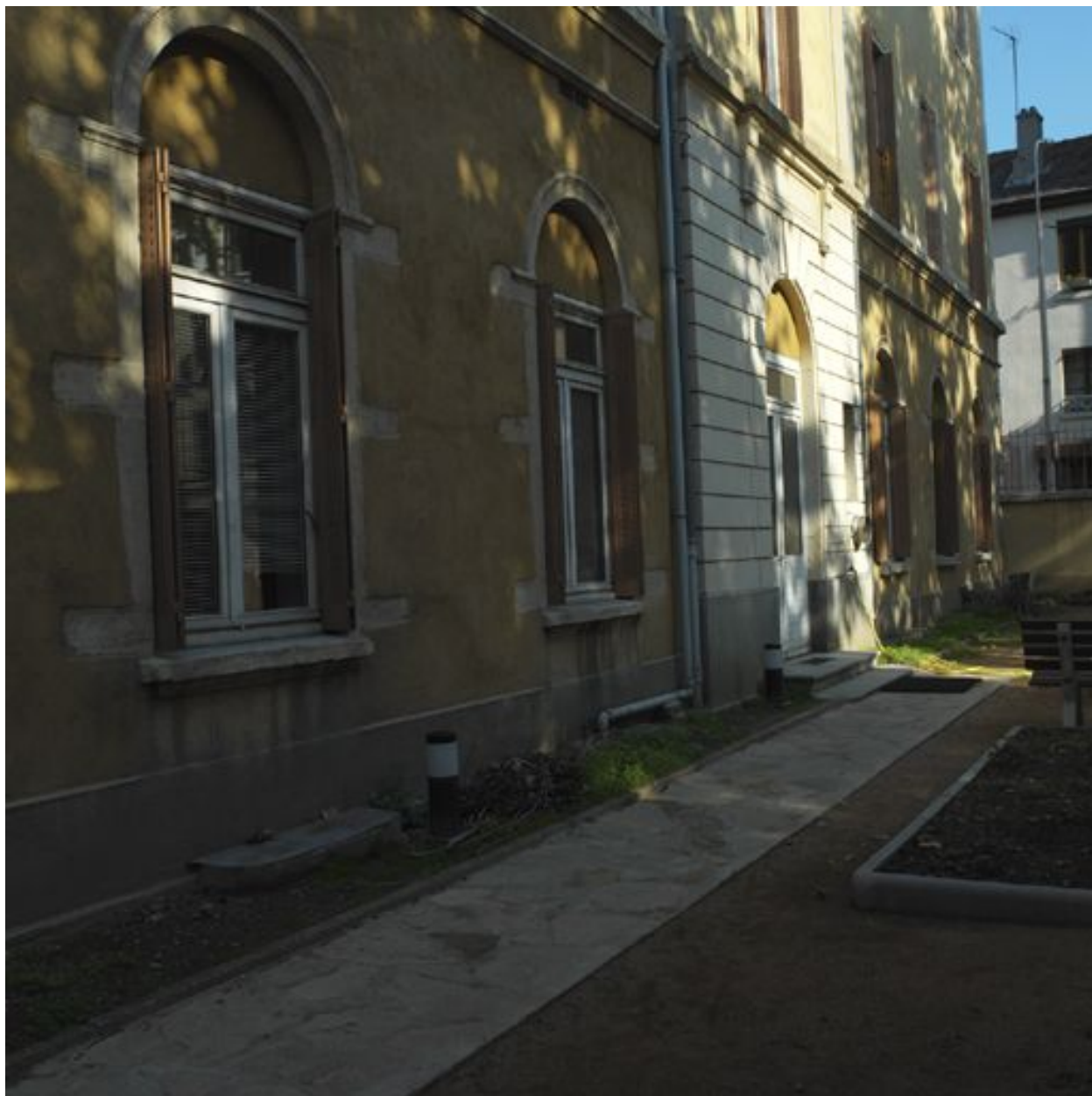
Elévation sud, depuis l'ouest
