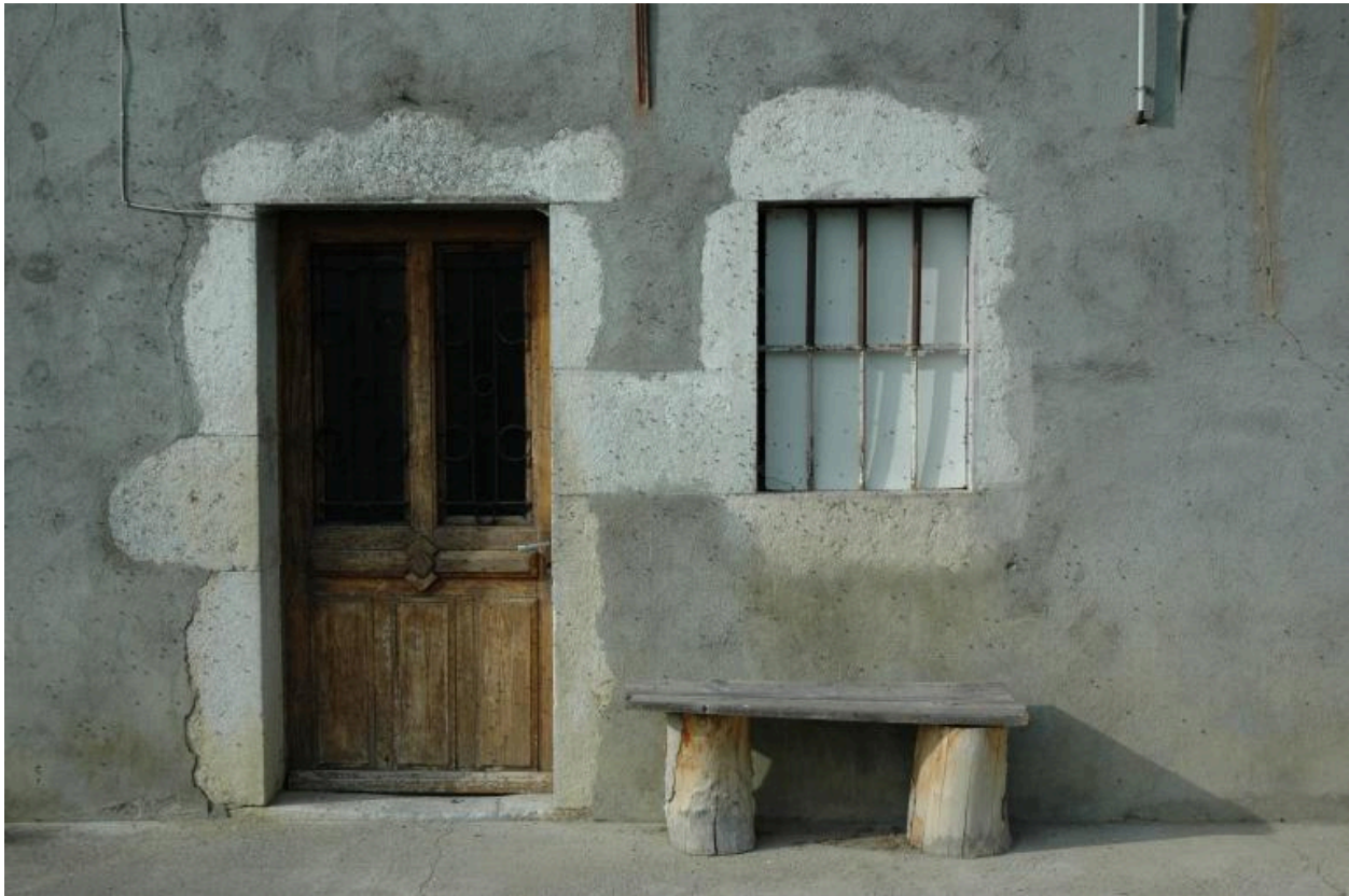
Détail de la façade : porte et fenêtre du rez-de-chaussée.
