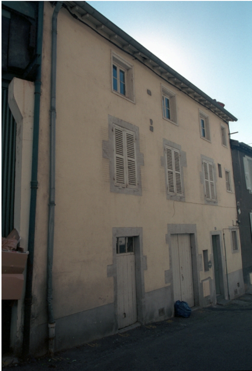
Boën, îlot 13, Ph. Raymond (rue) 20. Vue générale des façades sur rue.
