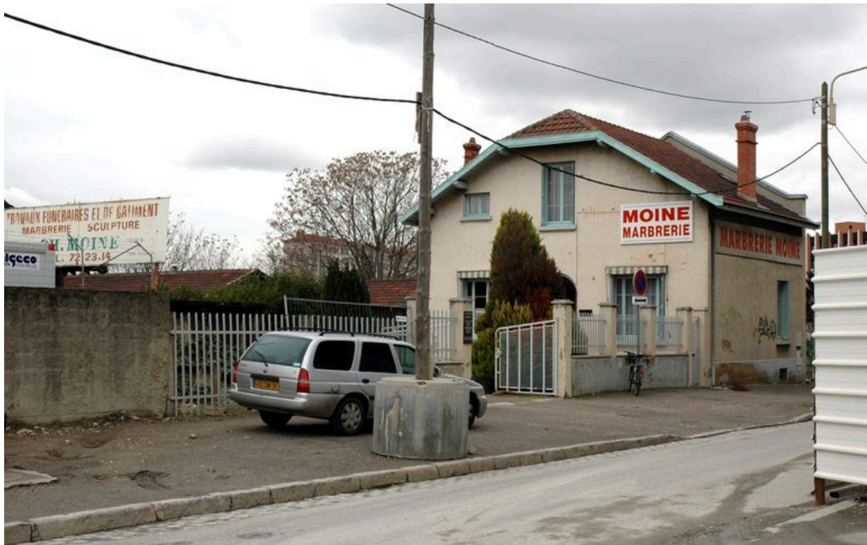
Vue de situation de la maison depuis la rue de l'Eternité
