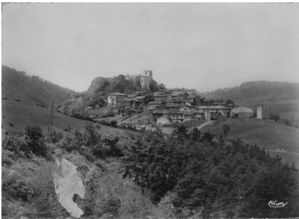
Rochefort (Loire) / 5 - Vue générale / Combier IMP. MACON (S.-et-L.) / Cim.
