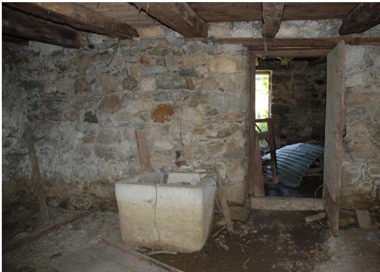
Vue intérieure de la cave nord-est (saloir).
