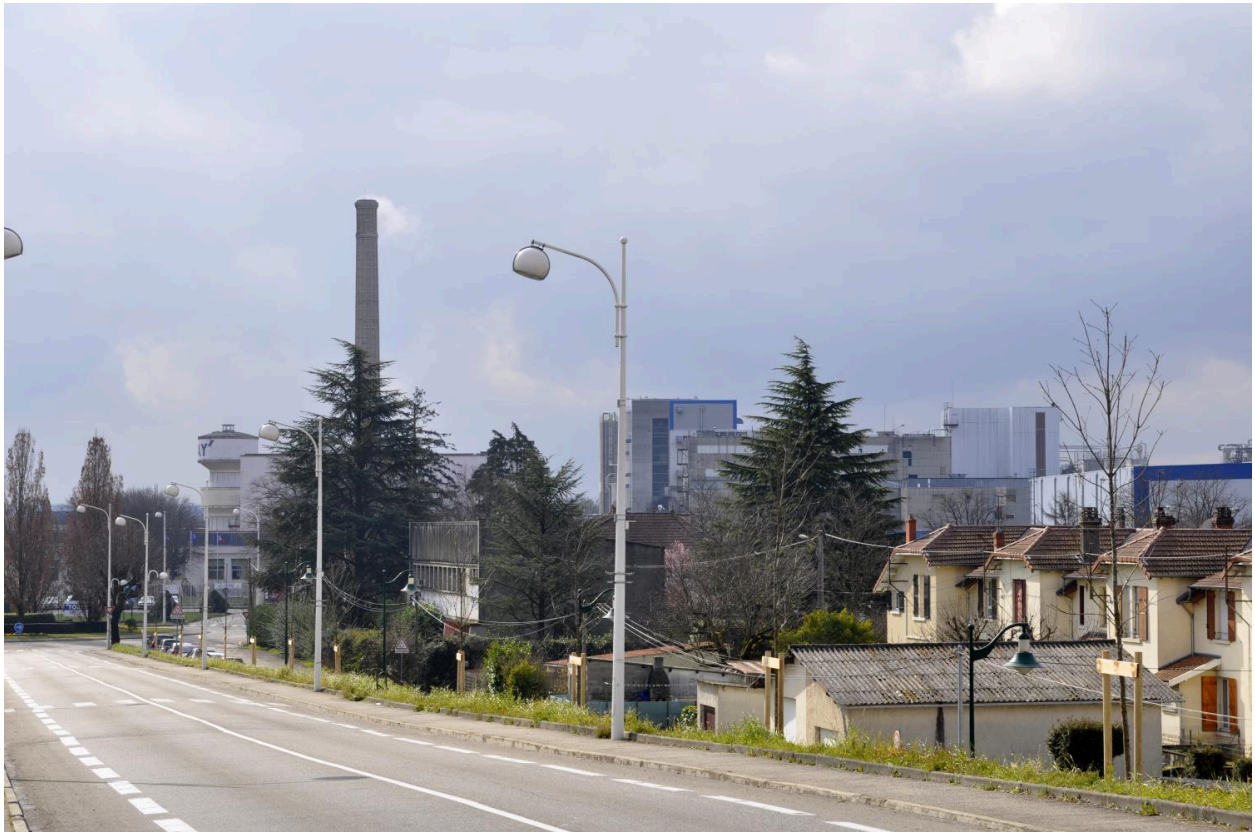
Château d'eau et cheminée vue de la voie ferrée
