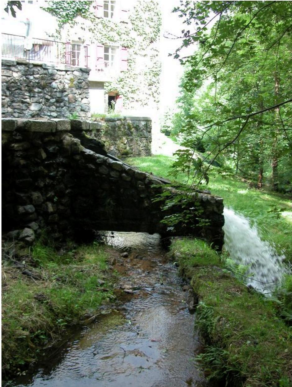
Ancien système de dérivation avec bassin. Ecoulement de l'eau hors du bassin, et bief d'alimentation des moulins en dessous.
