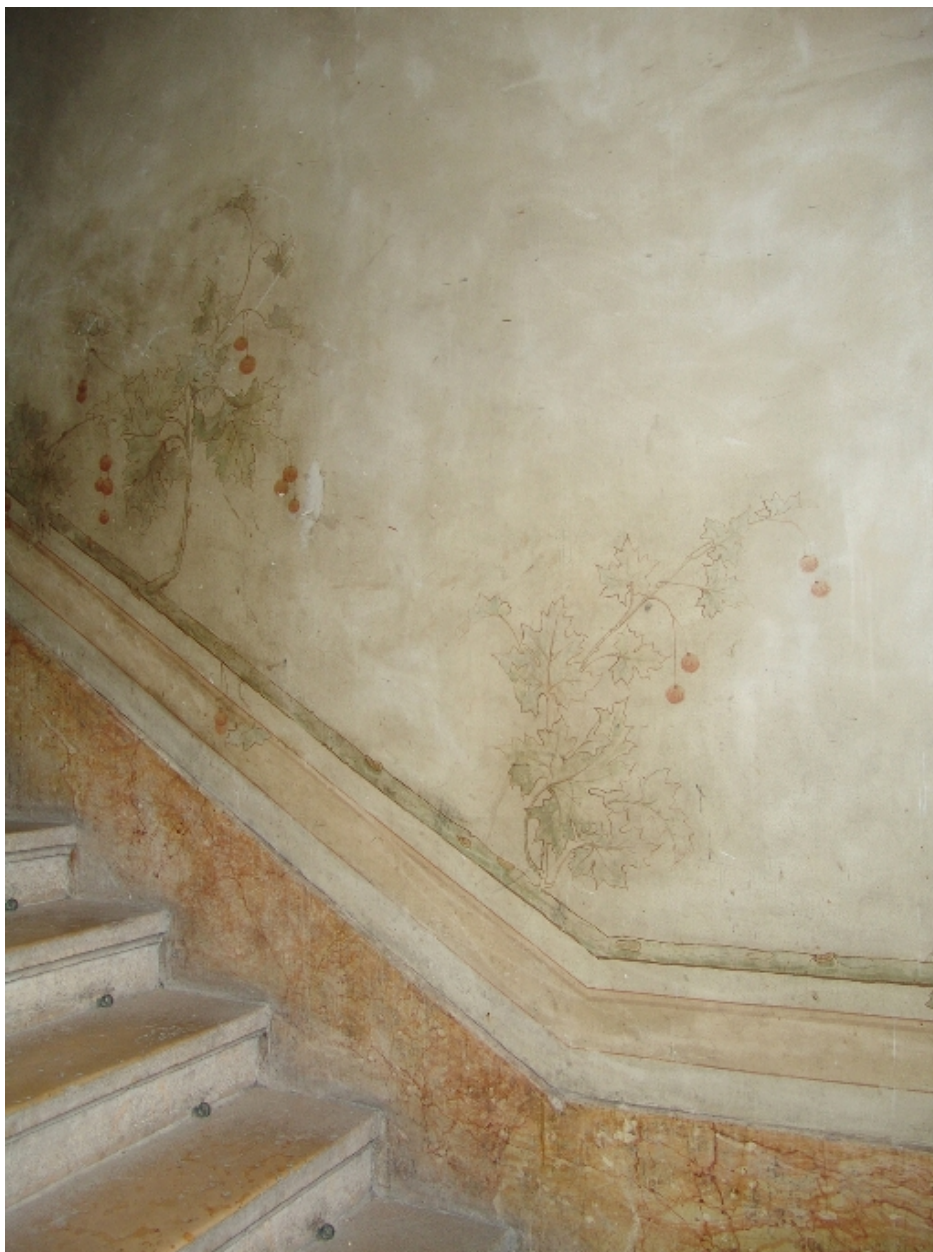
Décor peint de la cage d'escalier
