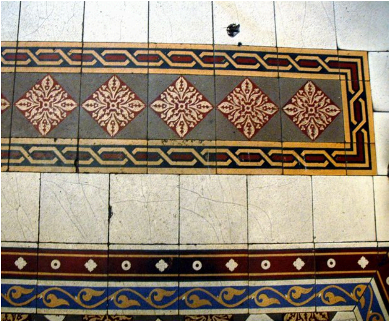
Carrelage du vestibule
