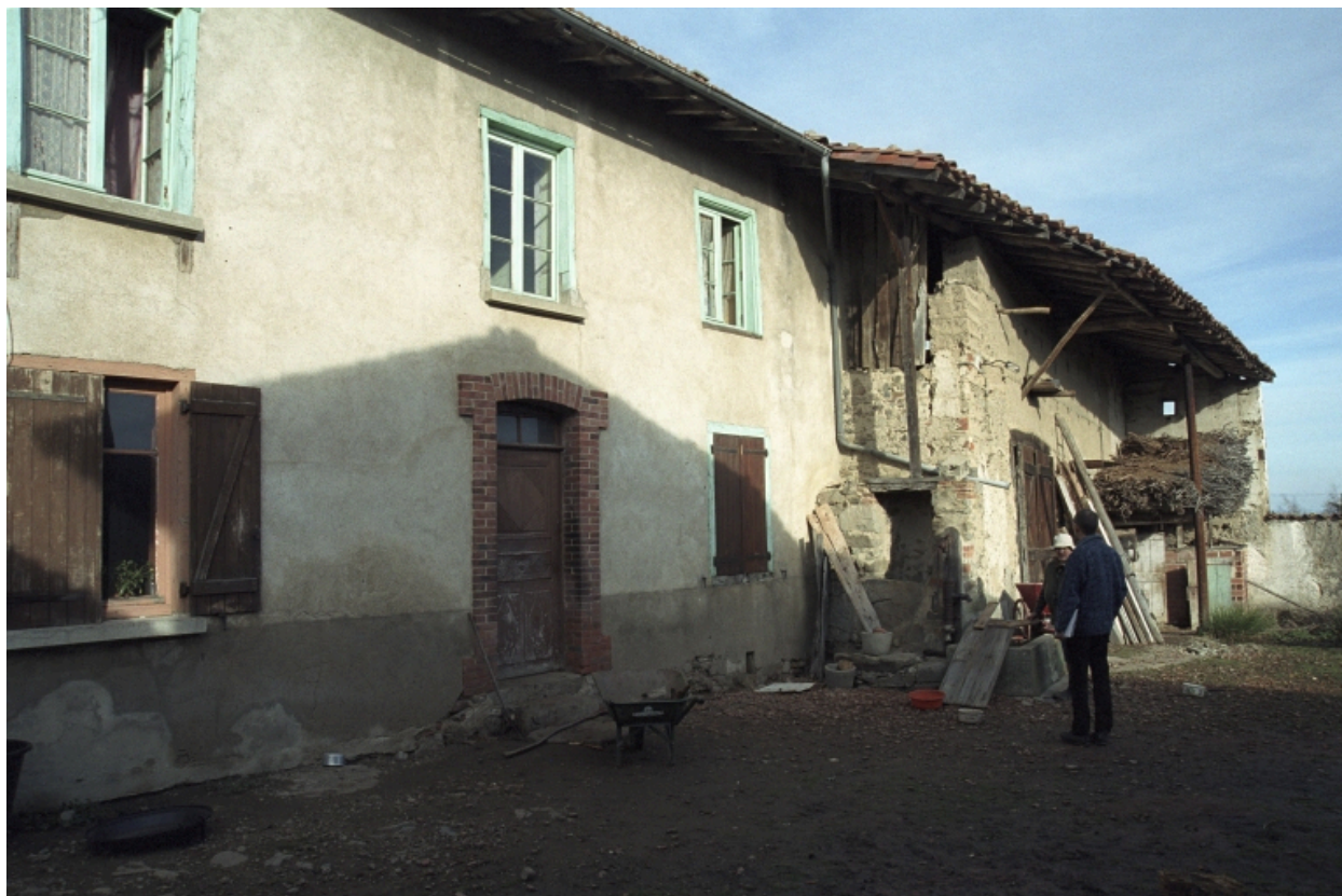
Saint-Sixte, Limes (1987 D1 177), type A1. Vue d'ensemble de la ferme.
