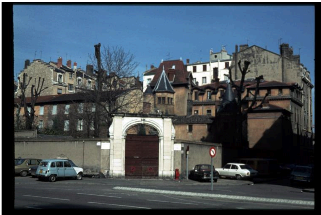
Vue de situation depuis la rue Garibaldi, dans les années 1970 (Arch. mun. Lyon, photographie, 6 PH 00448).
