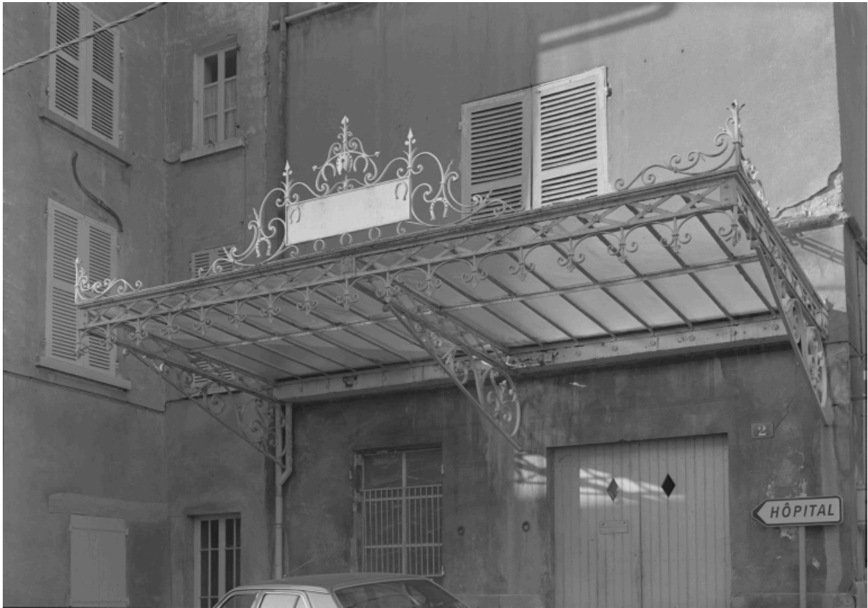
Marquise d'atelier de maréchal-ferrant, sur la rue des Halles.
