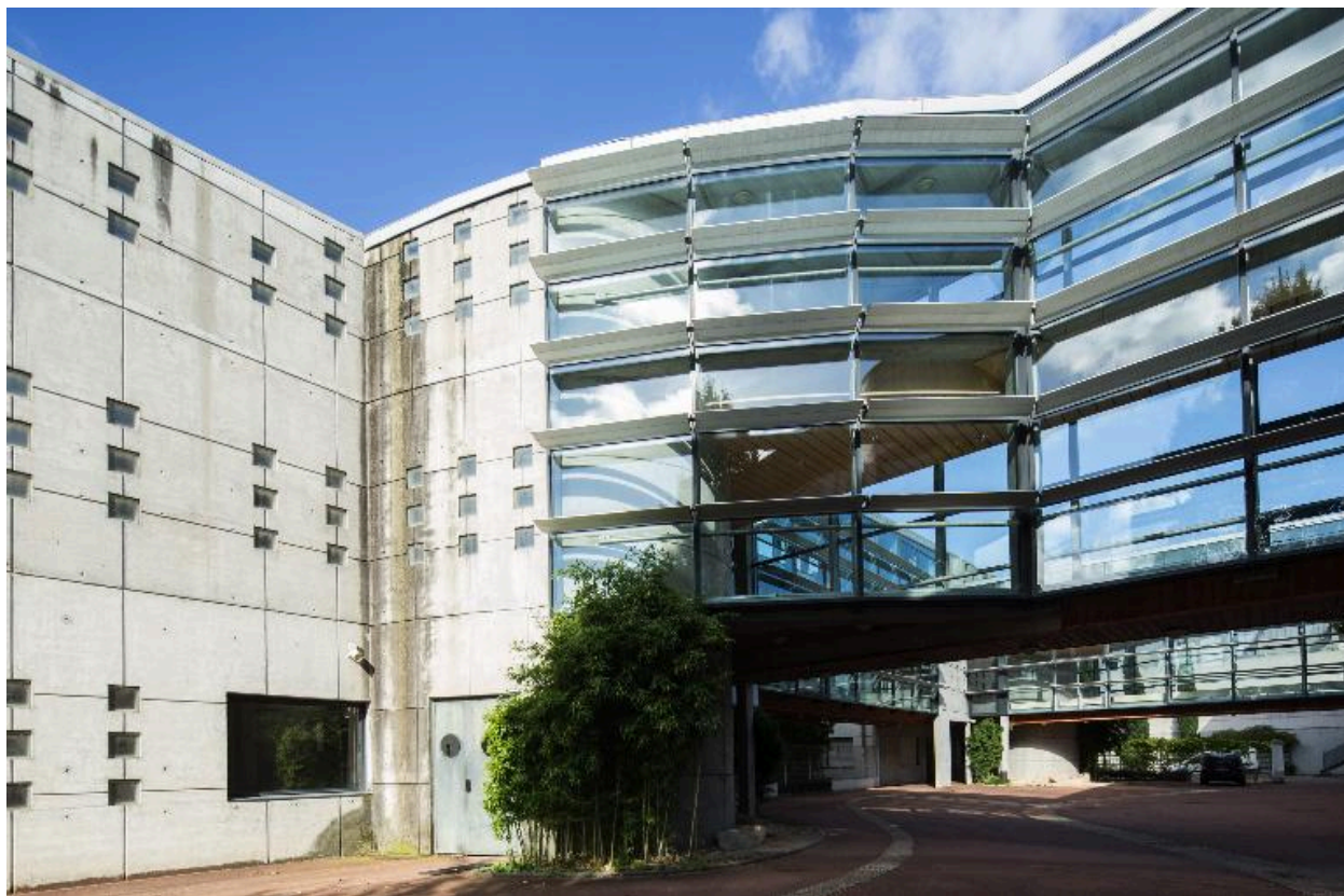
Passerelle H reliant les bâtiments B et E
