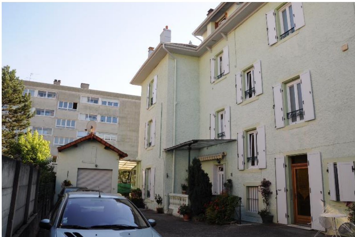
Cour et façade postérieure, vue générale
