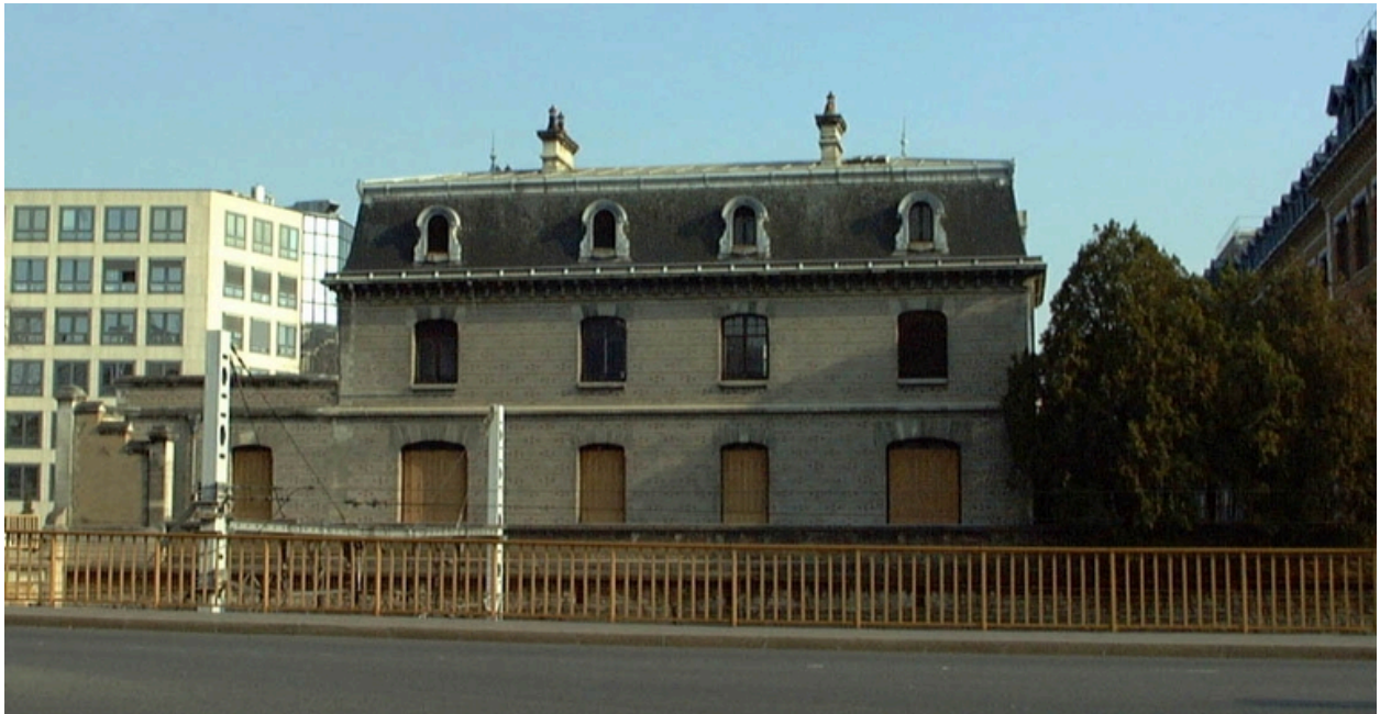
Maison du directeur, vue ouest
