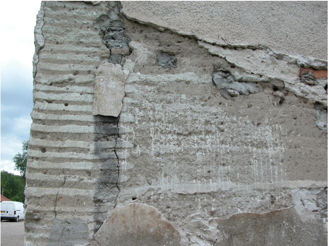
Vue de la ferme : détail du pisé de la grange-étable sud.
