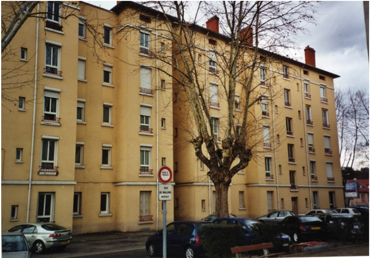
Vue sud-ouest, 55, 53, 51 rue du Bourbonnais (BP138), façade arrière sud avec parking et accès sur cour
