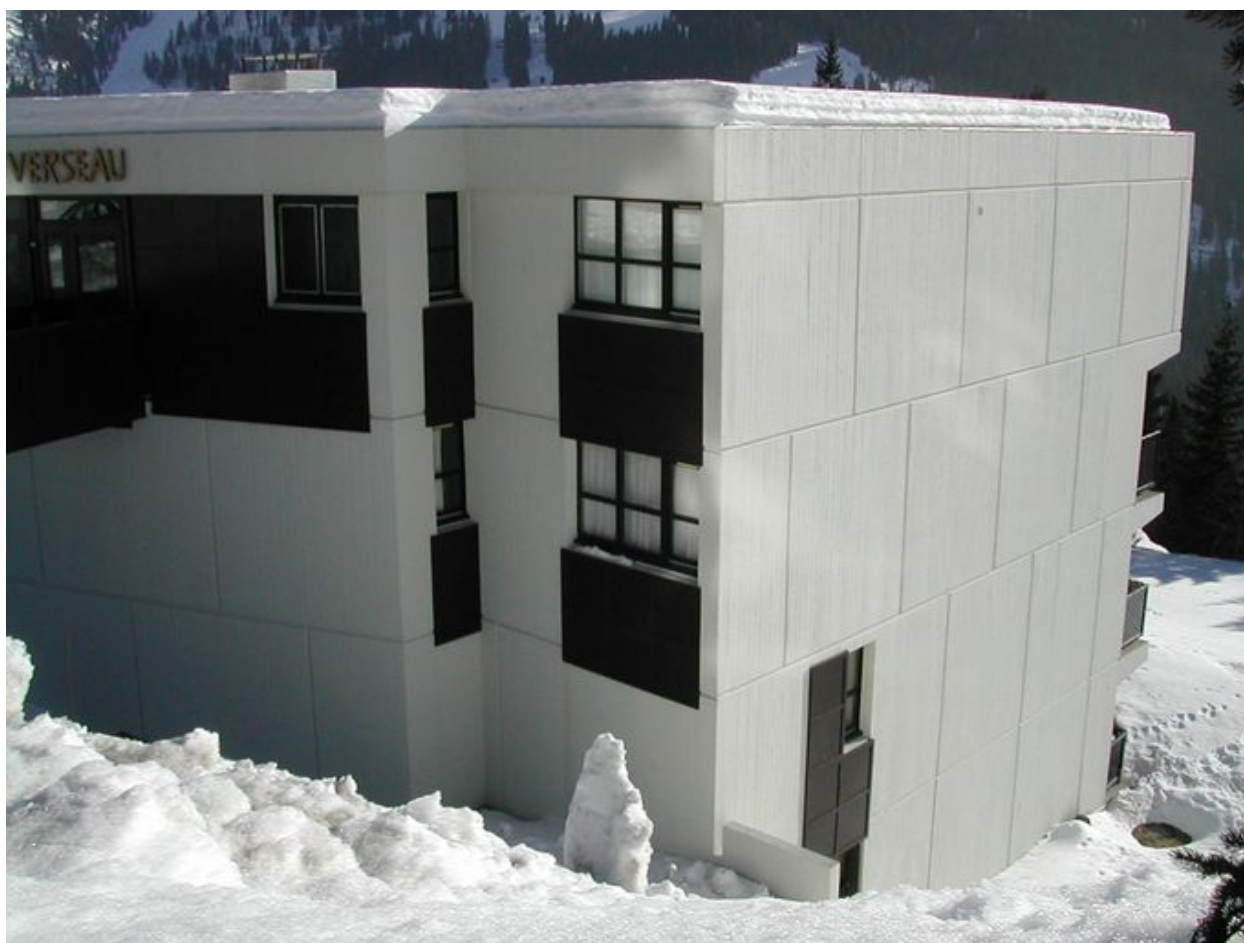
Vue depuis le nord-ouest, le pignon occidental
