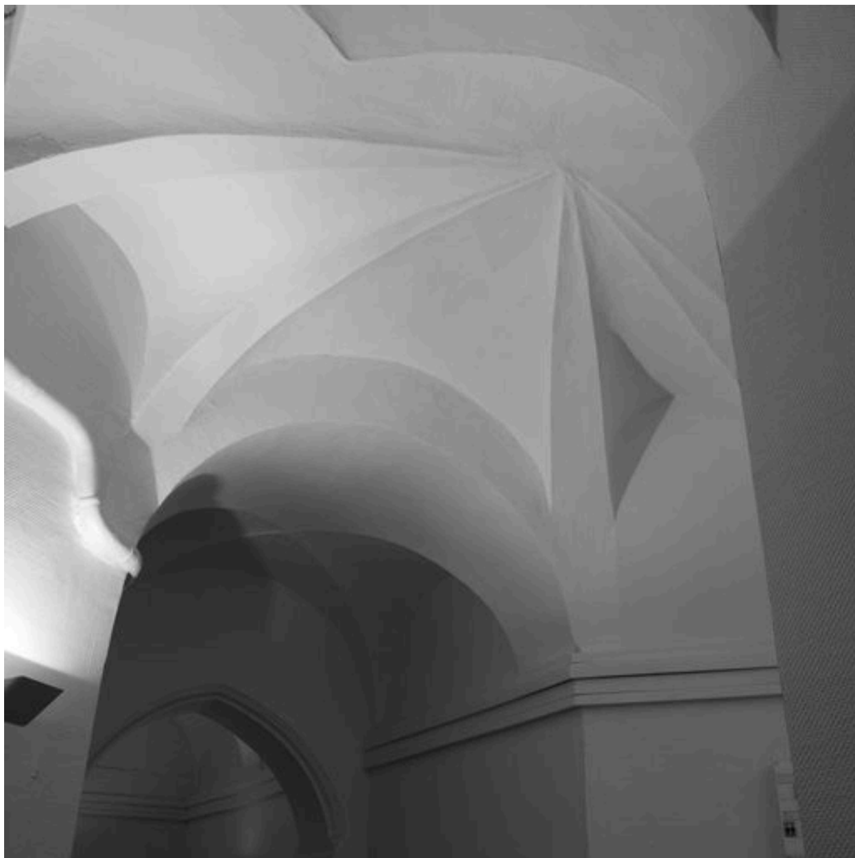
Escalier, voûte du palier du rez-de-chaussée
