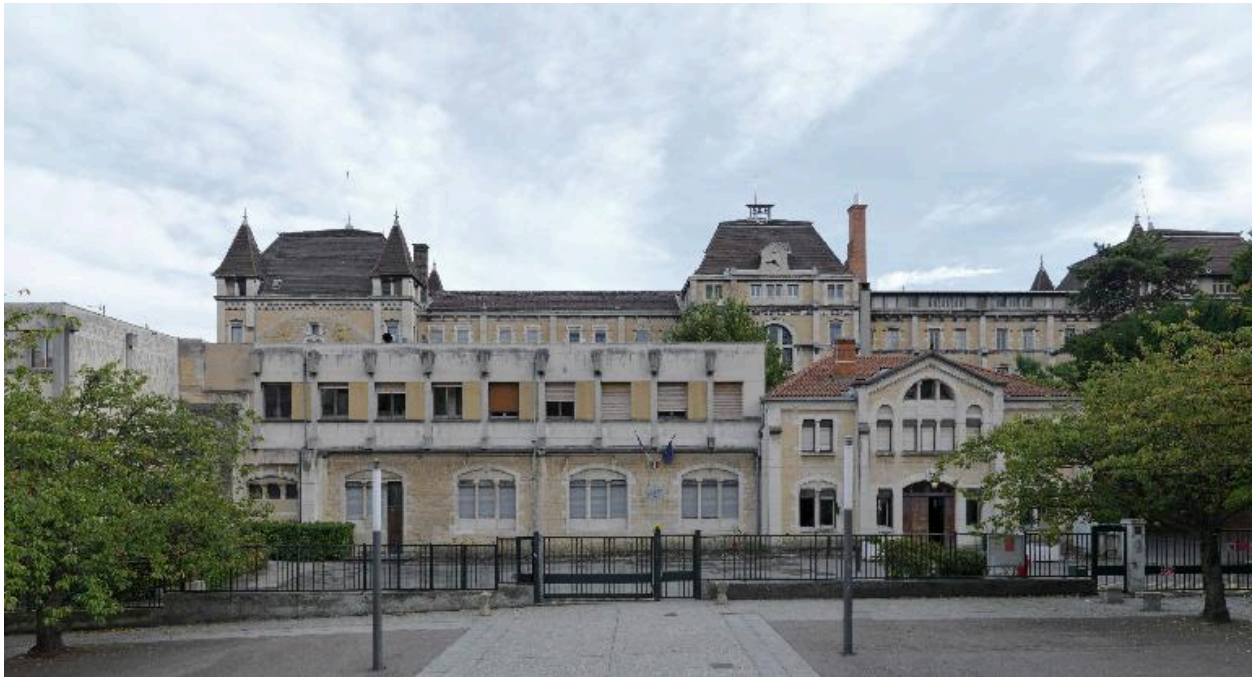
Vue d'ensemble depuis le nord-ouest : porterie et corps de bâtiment principal
