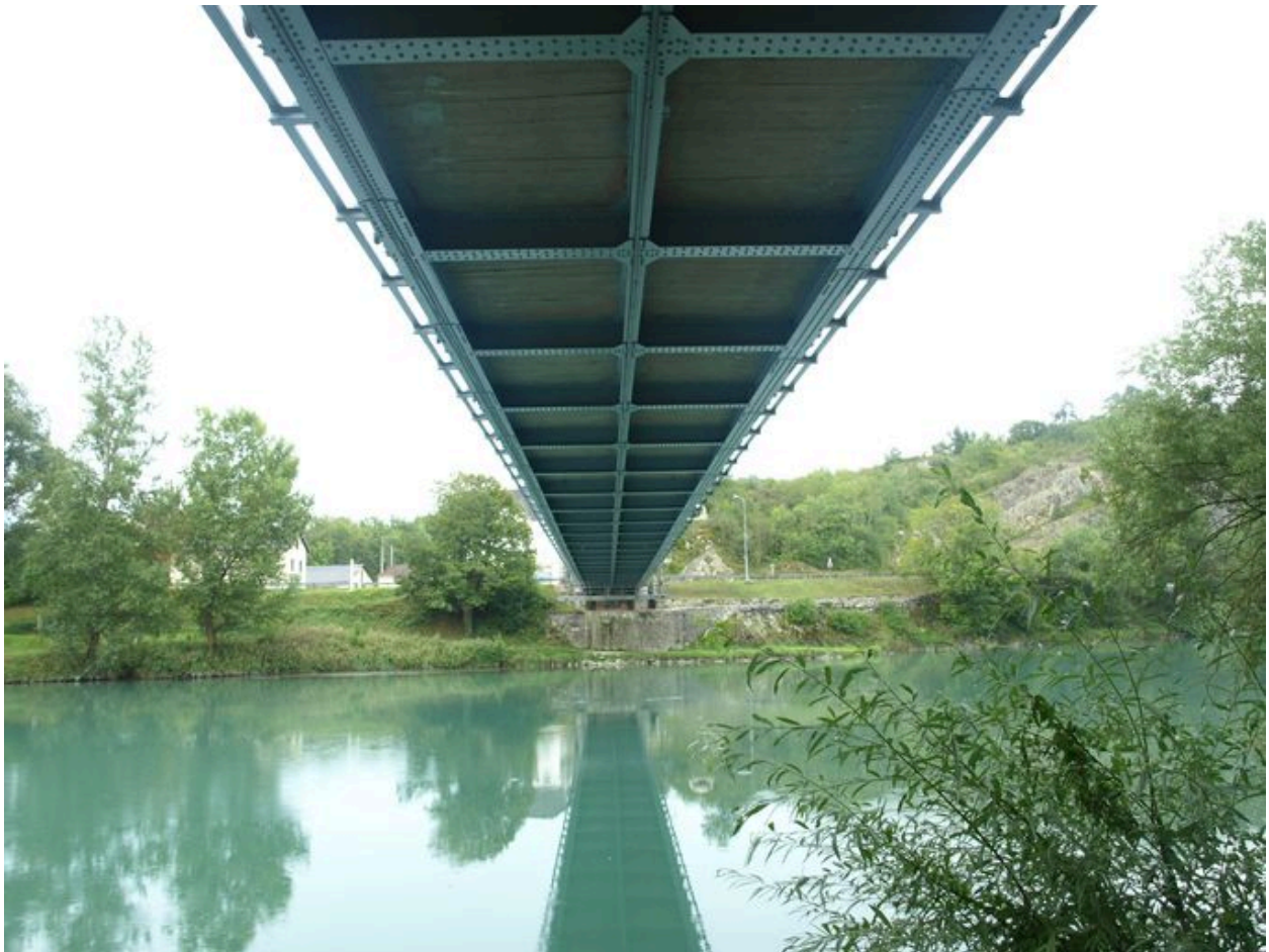
Vue générale, de dessous, tablier (depuis la rive droite)
