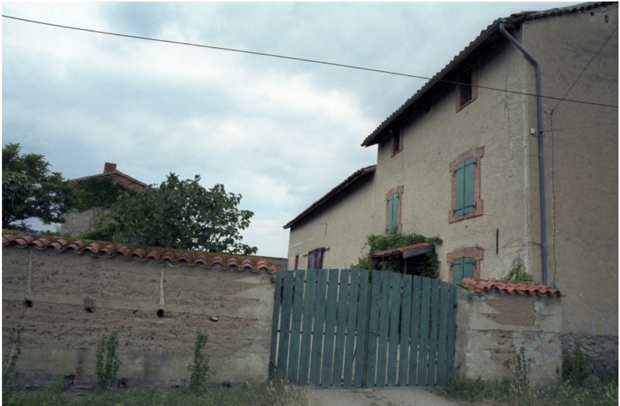
Montverdun, Chanteperdrix (1986 ZA 83 à 85), type A1. Vue d'ensemble des bâtiments depuis la route.
