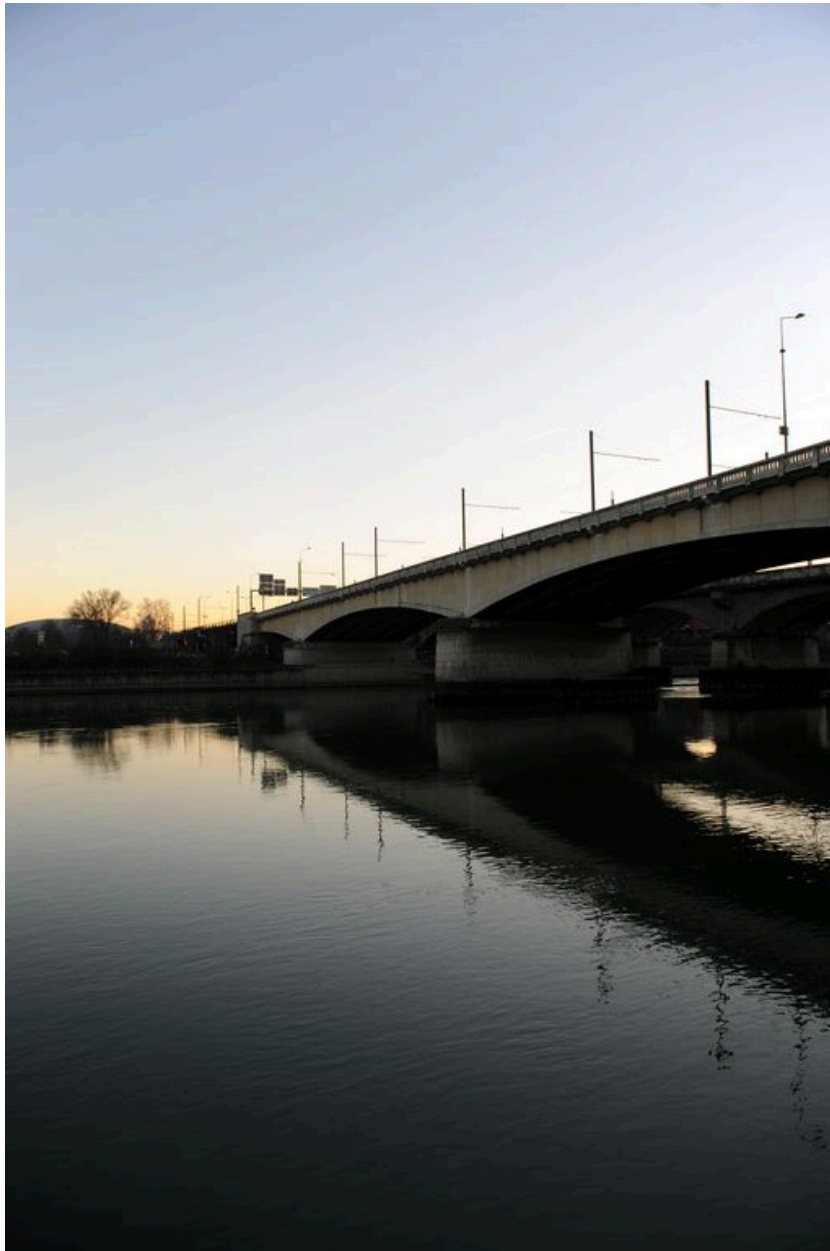
Vue partielle, travées senestres, face amont (depuis la rive droite)
