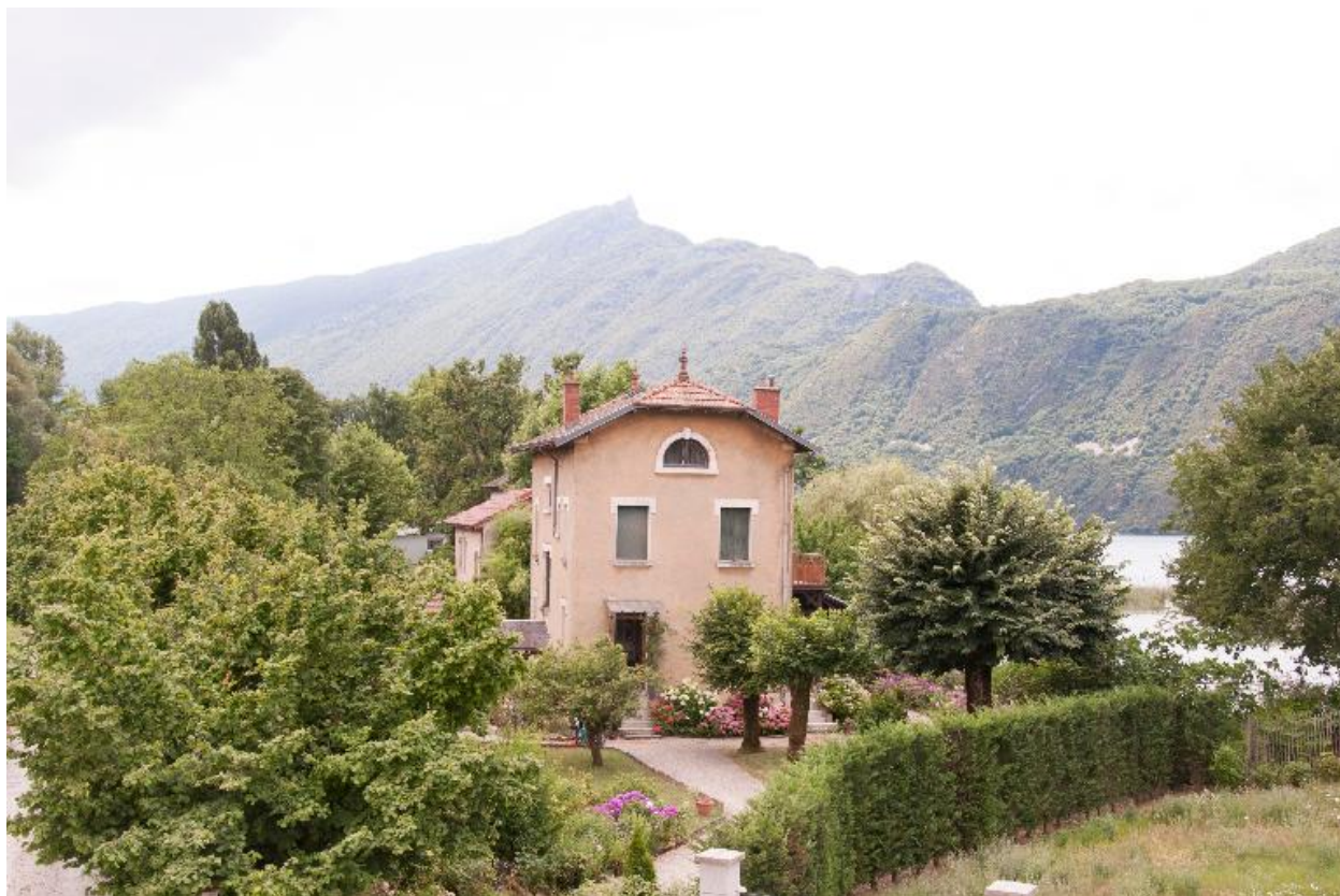
Vue d'ensemble de la propriété
