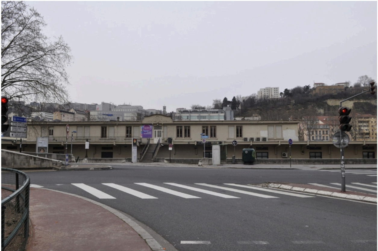
Vue est du bâtiment
