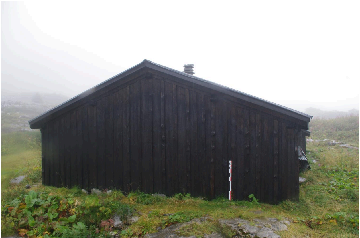
Vue du mur pignon nord
