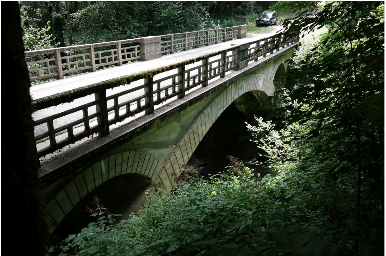
Pont du Parmand 1, vue sur les voûtes en face amont
