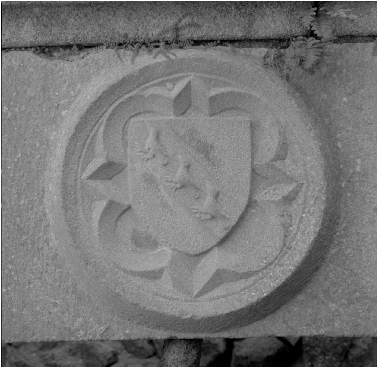
Détail des armoiries de la cheminée n°1.
