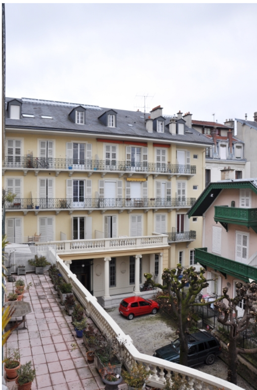
Terrasse en couverture de la salle à manger, partie est
