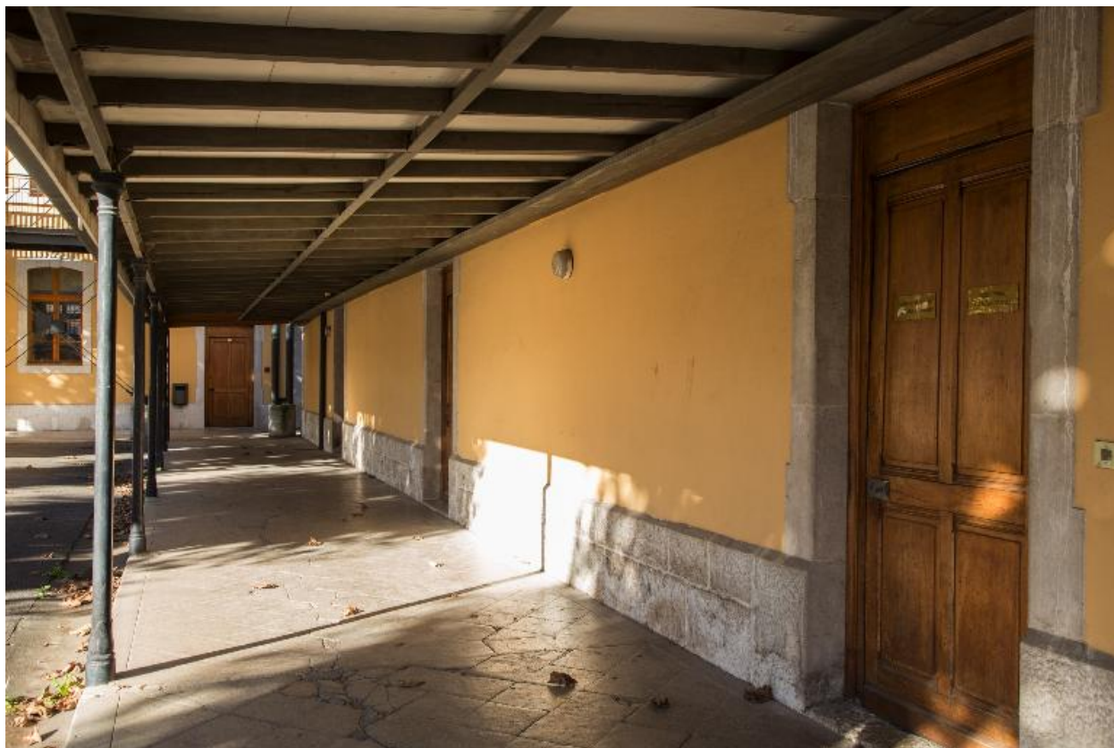
Cour 3 : galerie rez-de-chaussée côté est.
