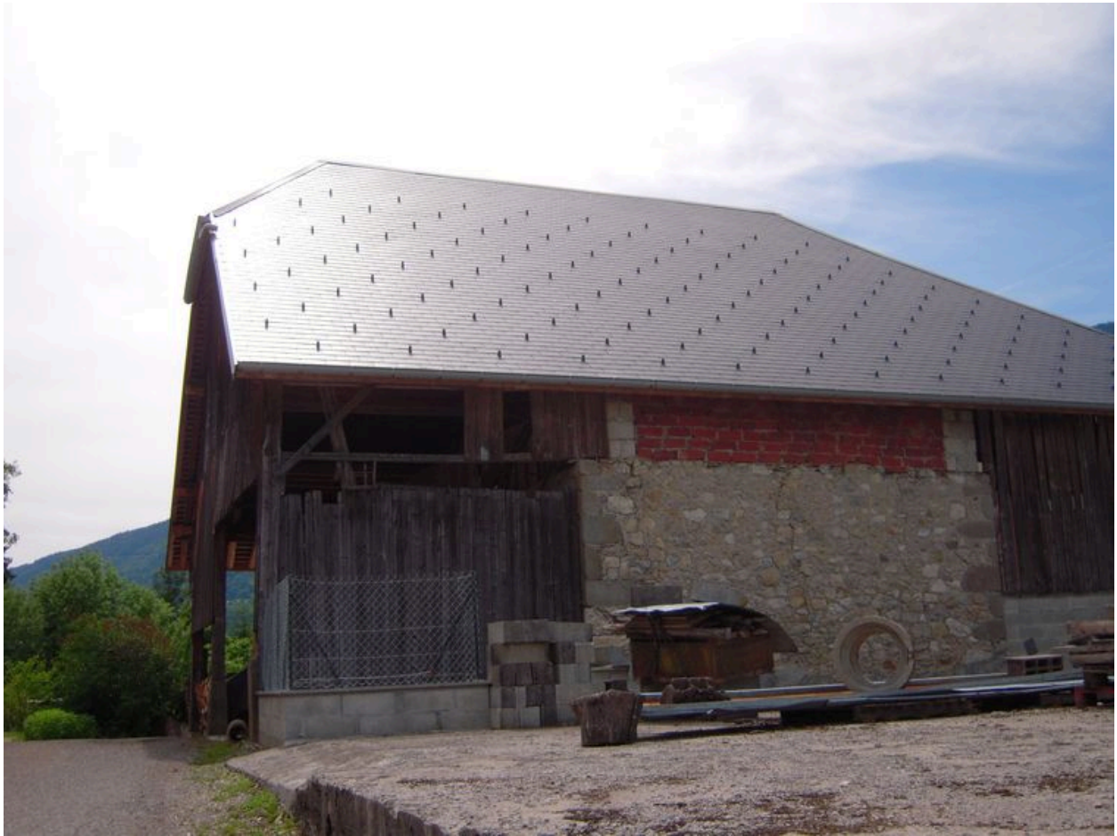
Vue de la façade nord.
