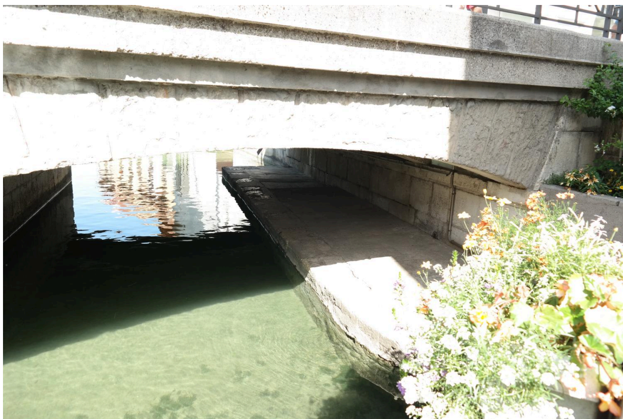
Pont de la République, détail de la culée
