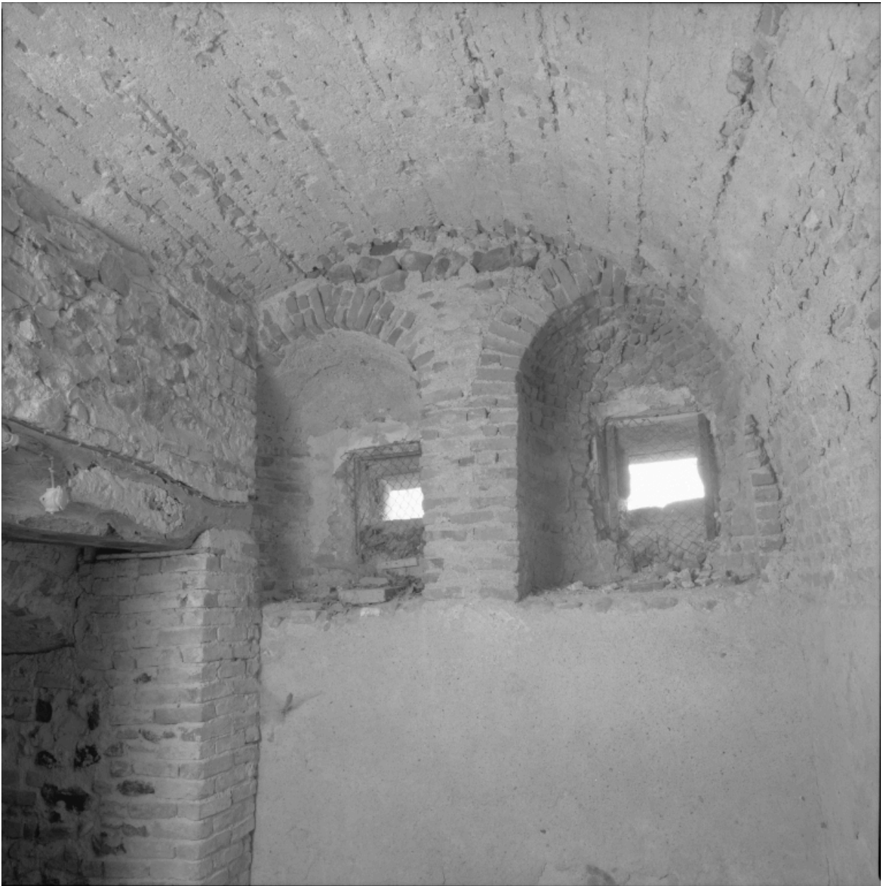
Bastion sud-est, sous-sol : détail des deux archères ouvrant sur le mur nord du bastion.
