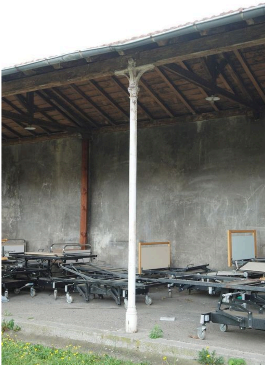
Promenoir, partie nord-est : charpente et colonnette en fonte
