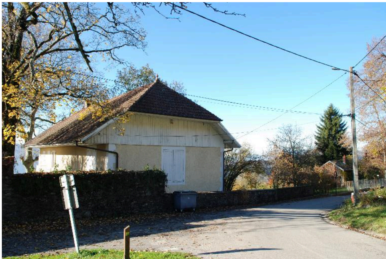
Sous les Côtes, maison bourgeoise la Maison Blanche, 2014 C2 251, 259. Vue d'ensemble de trois-quarts avant droit.
