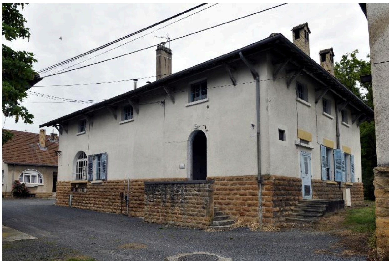
La boulangerie, élévation postérieure
