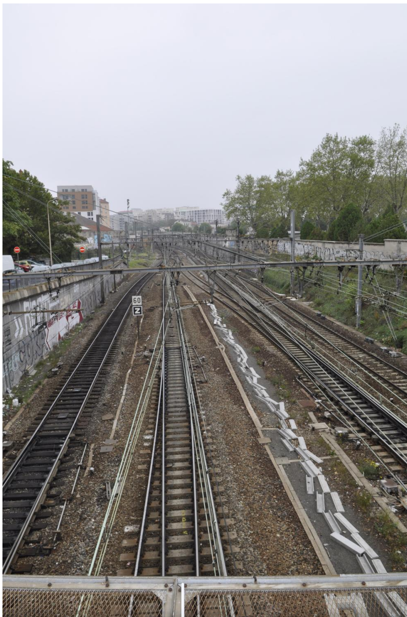
Voies ferrées à proximité du site
