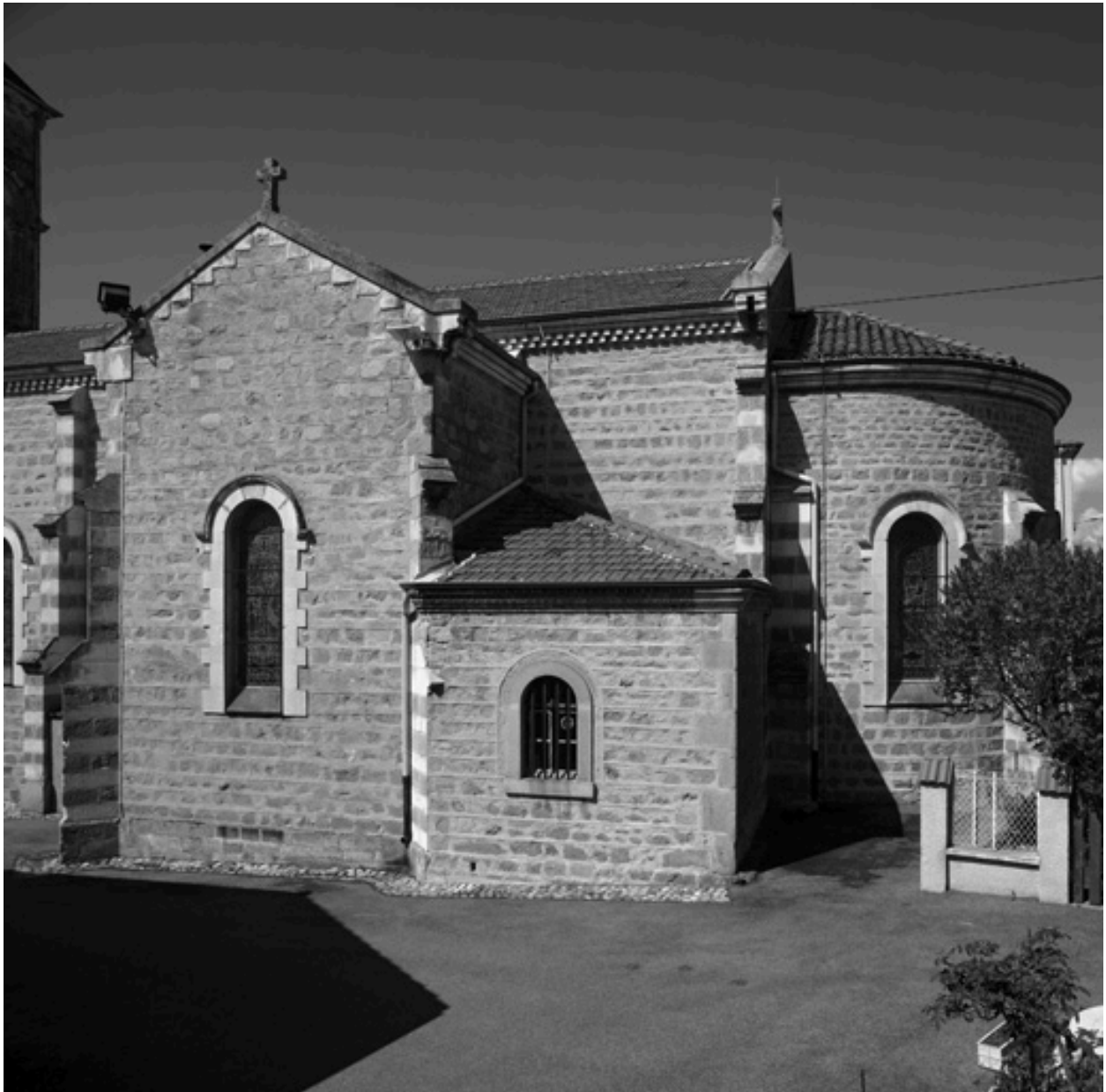
Vue latérale depuis le sud (transept, sacristie et chevet).
